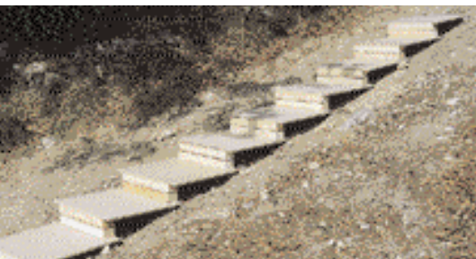
Mit Spanplatten und Kanthölzern wird das Steigungsmaß einer Treppe erprobt
